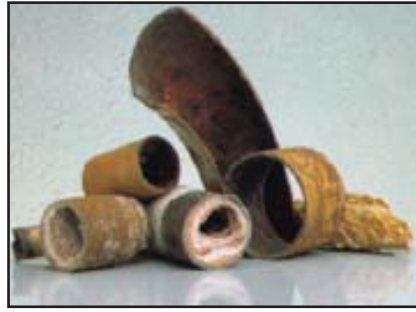
Taşlama ve korozyon sonrası oluşabilecek muhtemel görüntü
